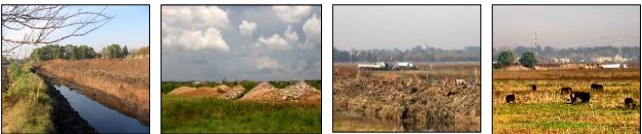
Obras que la firma Covelia realiza en terrenos de Santa Catalina adquiridos ilegítimamente (marzo-junio 2009)
